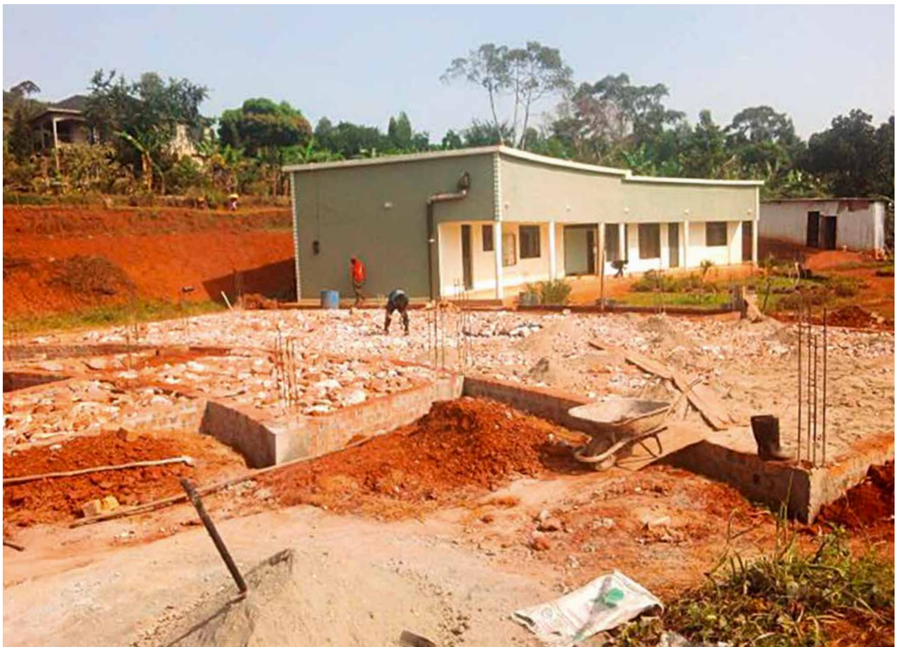
Fortschritt auf dem Bauplatz vor der Gesundheitsstation
