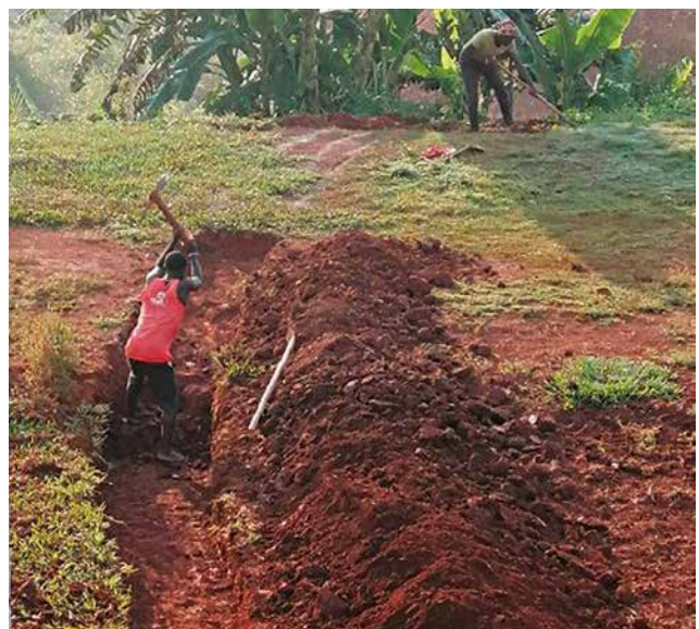
Arbeiten am Fundament
