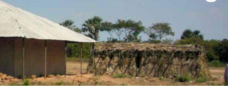
Neubau Kinak Behelfsschule · Januar 2014
